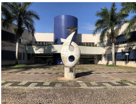
Prédio da Reitoria da UFG, em Goiânia. Foto: Laczkowski (CC BY-SA 4.0), via Wikimedia Commons
