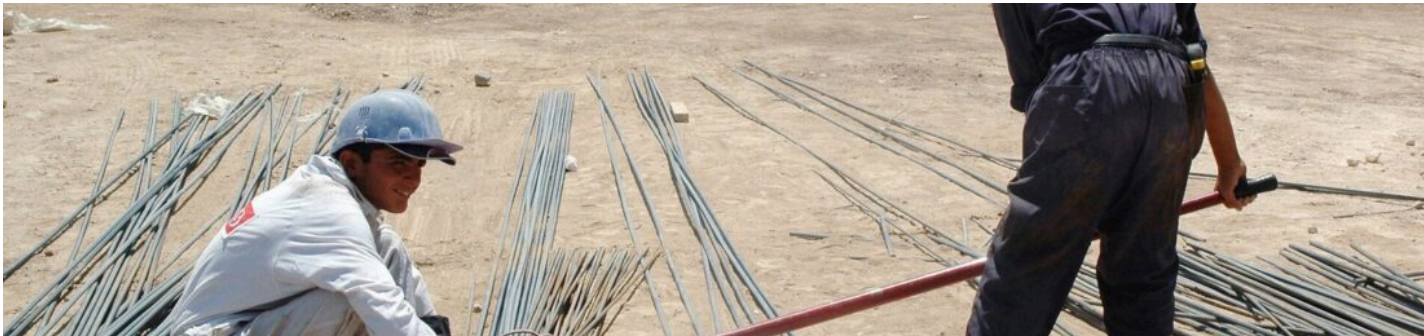
Imagem ilustrativa: operários preparam a ferragem de um pilar na construção de uma unidade de saúde. Foto: Jim Gordan/Departamento de Defesa dos EUA (domínio público), via Wikimedia Commons
