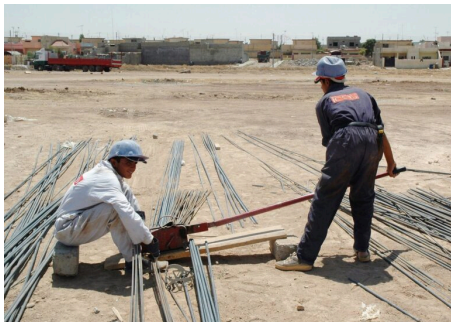
Imagem ilustrativa: operários preparam a ferragem de um pilar na construção de uma unidade de saúde. Foto: Jim Gordan/Departamento de Defesa dos EUA (domínio público), via Wikimedia Commons
