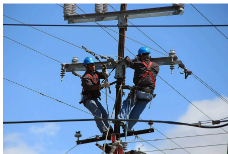
Imagem ilustrativa: eletricitistas em manutenção de rede. Foto: Fran Hogan (CC0, domínio público), via Wikimedia Commons
