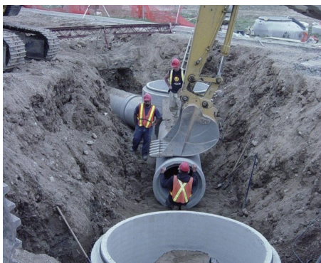
Imagem ilustrativa de instalação de galeria pluvial no Canadá. Não é a obra de Águas Lindas. Foto: Imprezzi1 (domínio público), via Wikimedia Commons
