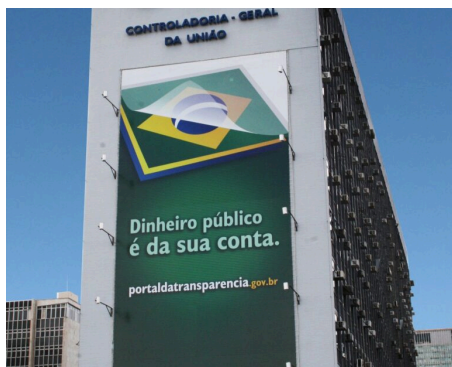
Sede da Controladoria-Geral da União, em Brasília. Foto: Ascom/CGU (CC BY-SA 4.0), via Wikimedia Commons
