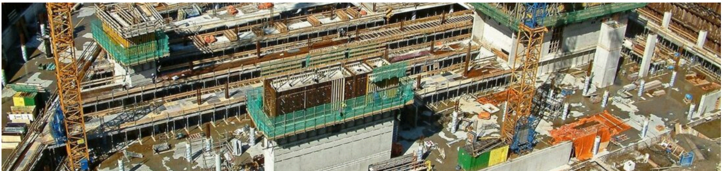
Foto ilustrativa de canteiro de obras com estrutura de concreto. Foto: Fons Heijnsbroek/Domínio público (CC0), via Wikimedia Commons
